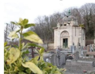
Le mausolée qui domine le cimetière de Folembray a été mis en sécurité. Il est aujourd'hui interdit d'y accéder.
