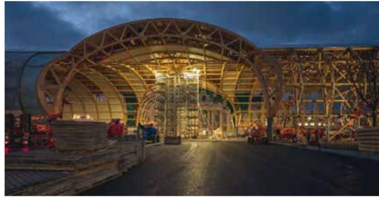
permet un assemblage sans retouche sur place. Au total 44 arches monumentales ont pu être assemblées sur place dans un délai de trois mois, permettant de respecter la contrainte temporelle du projet, qui doit être livré fin mars 2021.
