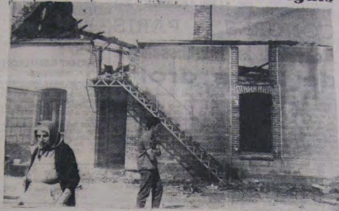
Mme Lucile Suchaud, en pleurs, quitte la maison d'habitation qui a été entièrement détruite
