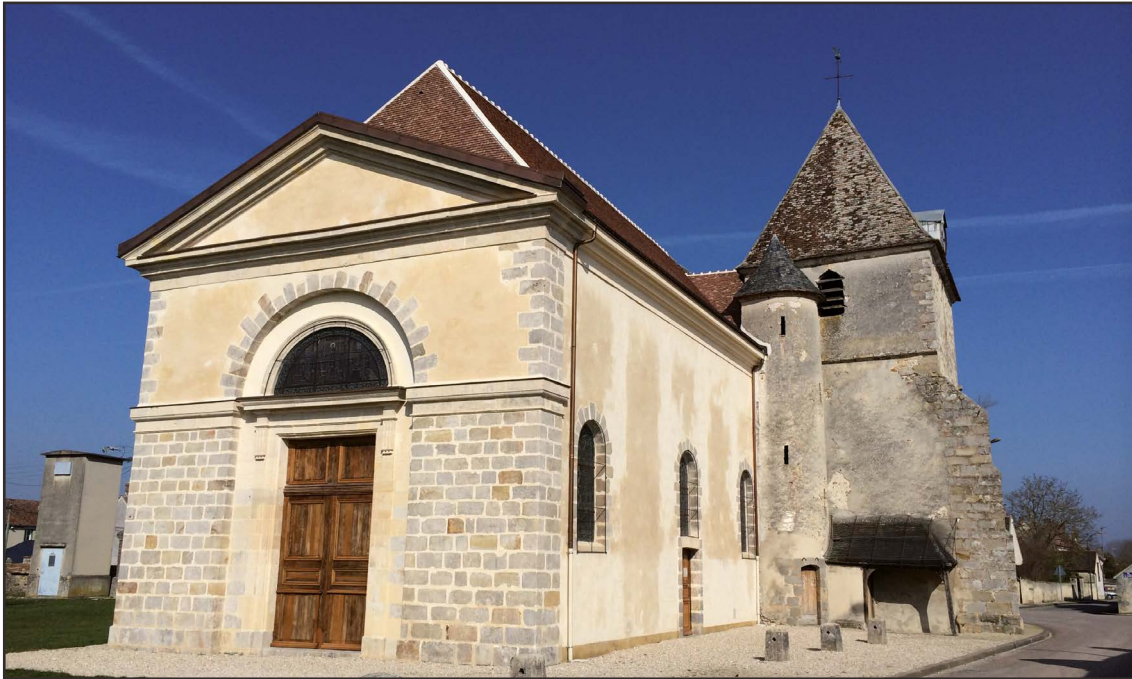
Eglise de La Motte Tilly, première phase de rénovation 2013 / 2014
